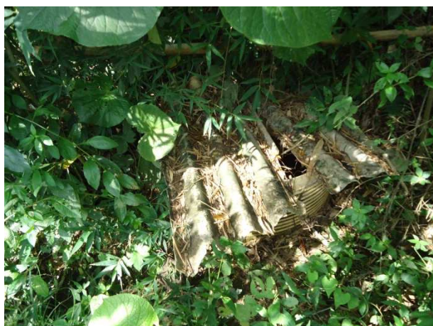
Foto c-2: Fossa negra na propriedade Rogério
